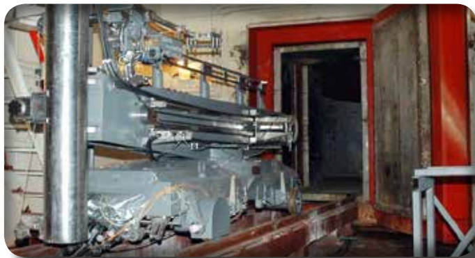
система зовнішнього контролю корпусу реактора (установка ЮУАЕС)
