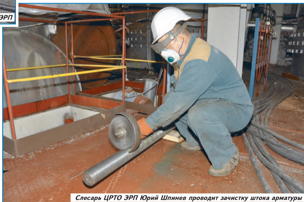
Зачистку корпуса под неразрушающий контроль металла проводит электрик ЭРП Анатолий Погурец
